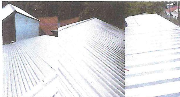
Foto 2: Así quedó instalada la lamina troquelada en el cuarto tecnológico y en los sanitarios.
