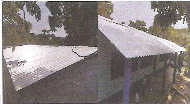
Foto 1: Así quedó instalada la lamina troquelada de las dos aulas.
