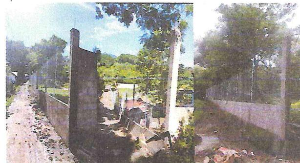
Foto 4: Finalización de la construcción del muro perimetral con block, tubo y malla galvanizada.
